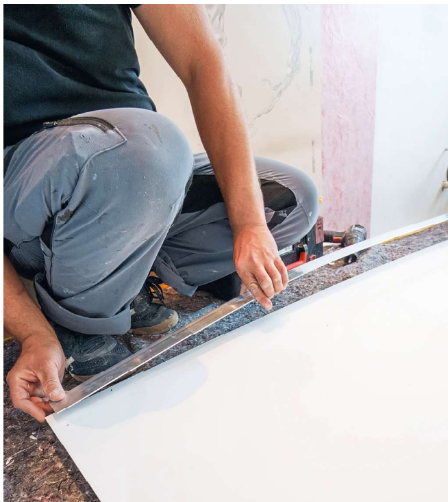
Vor Anbringung der Profile müssen diese entsprechend der Plattengröße gekürzt werden.
