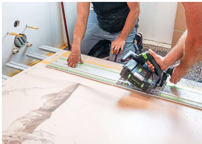
Bohrungen und Zuschnitt der Wandverkleidungsplatten erfolgen mit handelsüblichem Werkzeug – eine Spezialausrüstung wird nicht benötigt.
